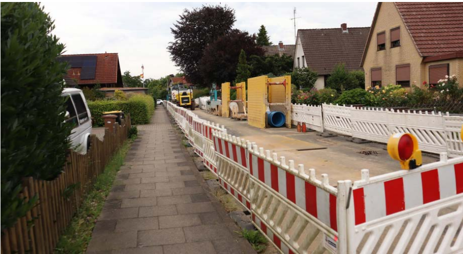
Sanierung Gerberstraße u. Vogelwege bis 2028
