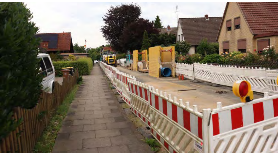
Sanierung Gerberstraße u. Vogelwege bis 2028
